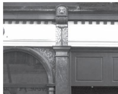
fig. 15 & 16 pilasters
